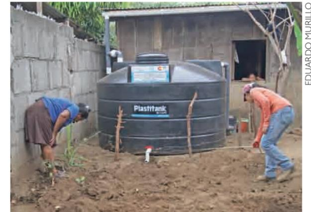
Para regar los huertos domésticos de Managua, se instalaron 430 sistemas de captación de agua de lluvia, cada uno conectado a un tanque con una capacidad de 5 000 litros.
